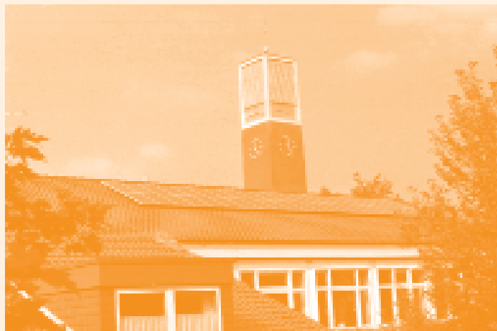
Photovoltaik-Anlage auf dem Dach des Gemeindehauses der Kreuzkchengemeinde in Herford Foto: Kai-Uwe Spanhofer
